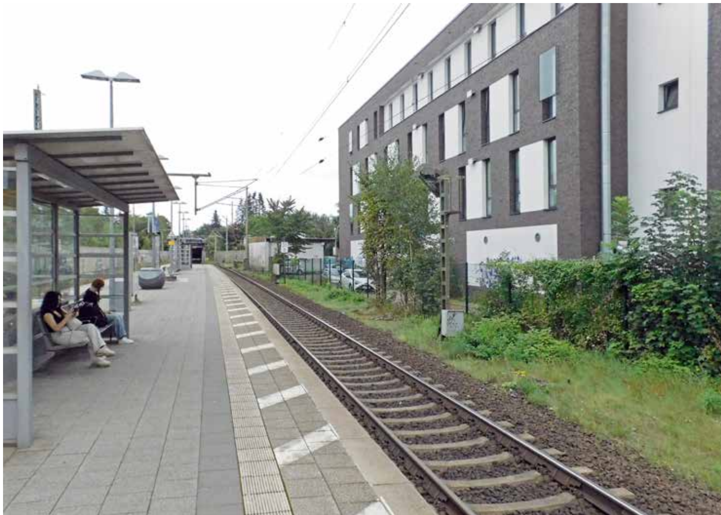
Bild 12 Bahnsteig Rahlstedt mit Blick auf das Gleis nach Lübeck, rechts im Bild der Neubaublock
